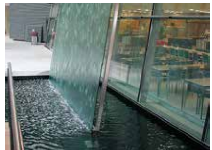
Wasserbecken Bürogebäude „Prisma“, Frankfurt a.M. (DE)
