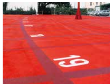
Roter Platz, Köpenick (DE) • Objekt: Öffentlicher Platz • Objektgröße: 1.022 m 2 • System: Triflex Preco Line 300
